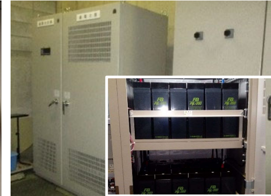
〈直流電源装置〉（非常用蓄電池）
